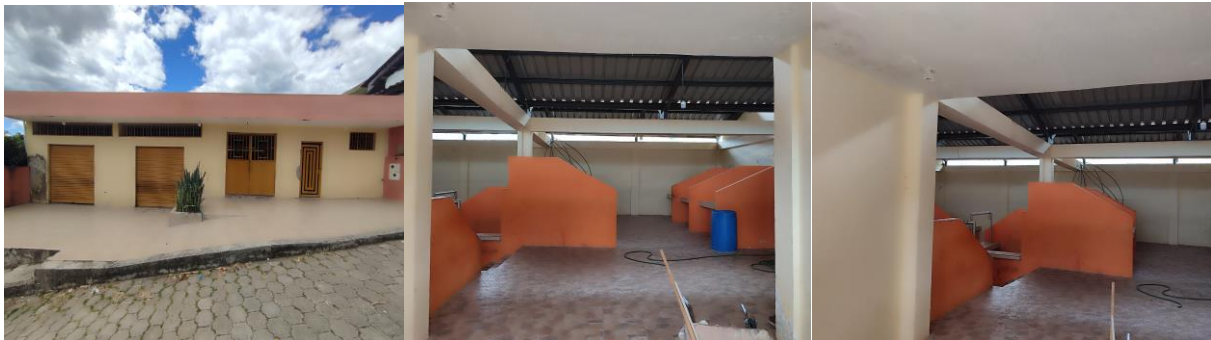
Imagen 25. Infraestructura del Mercado parroquial de Sacapalca
