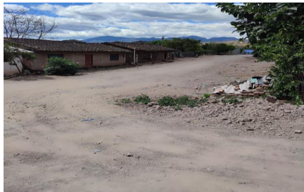
Imagen 30. Vía “Y Piñonales – Pilancay” - Sacapalca
